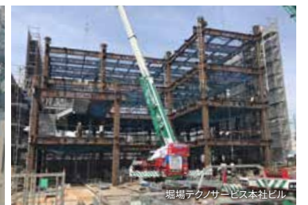
堺場テクノサービス本社ビル
